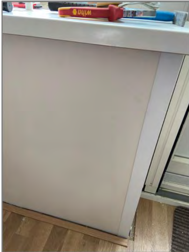
Binnenisolatie onder vensterbank, afgewerkt
