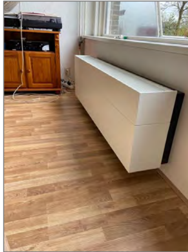
Convactor incl. ventilatie plus warmteterugwinning
