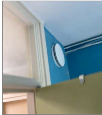
Ventilatie-doorvoeren voor centrale balansventilatie
